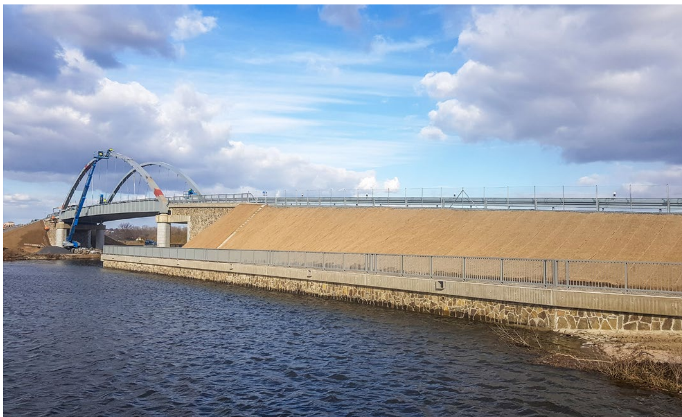
Most přes kanál Vraňany–Hořín březen 2021 dokončení ŘVC
